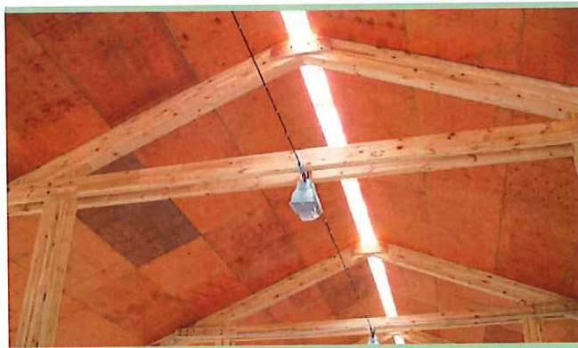
Животноводческий комплекс в п. Винзили, Тюменская обл. Подрядчик ОАО «Сибжилстрой» Cattle complex finished with Bakalized plywood in Vinzily village. Tyumen Region/ Contractor JSC «Sibgilstroy»
