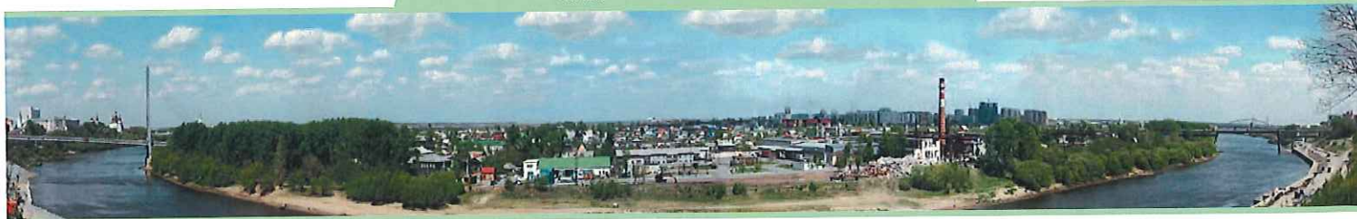
Старая производственная площадка. Old site
