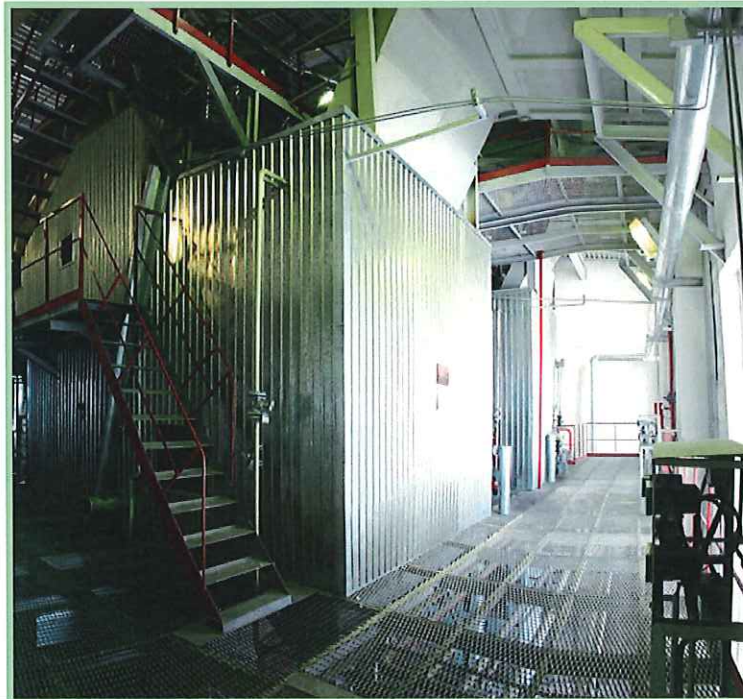
Паровая котельная с мощностью 1-ой очереди — 11,5 Гкал, работающая на биотопливе. Контроль и управление энергетическим хозяйством осуществляется с дистанционного пульта управления. Steam boiler room with the capacity of 11.5Gcal operatin on biofuels. The control and monitoring are carried from the remote control room.
