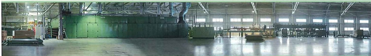
Автоматическая линия сушки и сортировки сухого шпона. Это высокопроизводительная линия с гарантированными качественными показателями. Automatic drying and grading line. This is a high producing line with guaranteed quality indicators.
