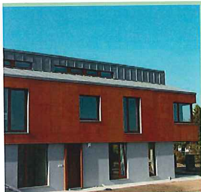
Отделка фасада дома бакелизированной фанерой Exterior decoration with bakelized plywood
